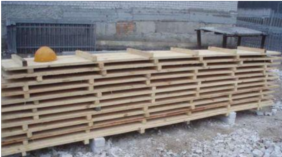
Рисунок 3.15- Щити розбірно-переставної опалубки
